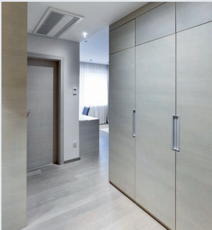
Zdravotné stredisko Park Igls v Innsbrucku, EDMUND SPARER Klima & Kältetechnik GmbH
